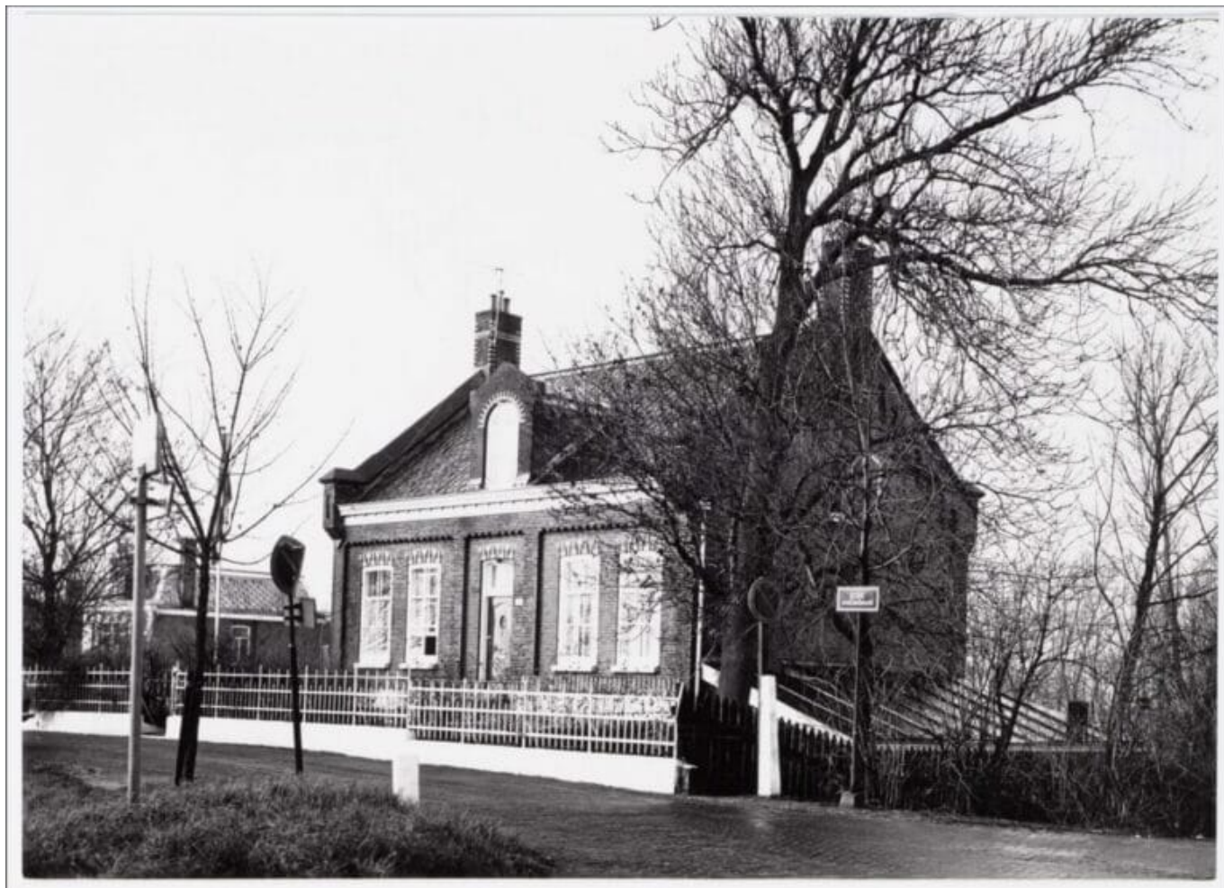
Schellingwoude: Ijdijk. Huis van de sluismeester van de Oranjesluizen in de knie van de Schellingwouderdijk en de Noorder Ijdijk. Bewoond sinds juli 1879.
