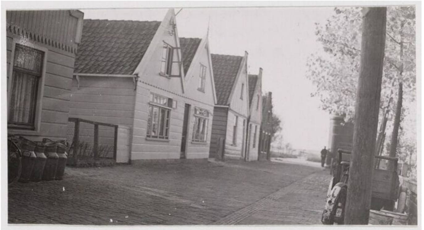
Kerklaan, gezien in westelijke richting. Links B 81-86
