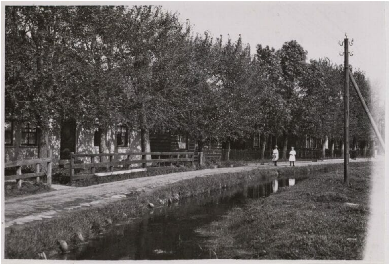
Dorpsweg in oostelijke richting gezien vanaf nummer C 33
