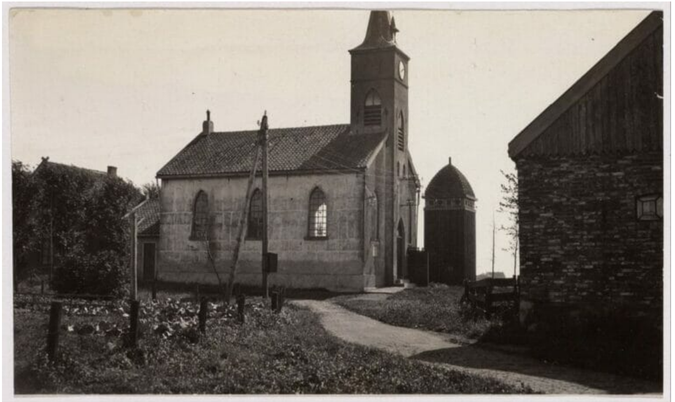
NH-Kerk en Dorpsweg in zuidelijke richting gezien naar C 43 - C 45
