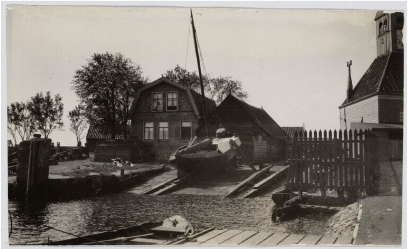
Haven, gezien in zuidwestelijke richting.
