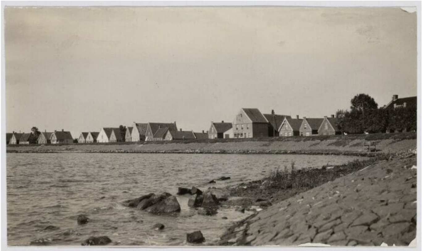
Durgerdammerdijk B18-B49. Het hoge huis is het café (nu gesloten) naast het Kerkepad.
