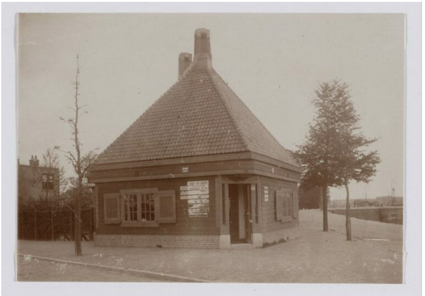
Buiksloterweg 9B, het politieposthuis met op de achtergrond schutsluis Willem I.
