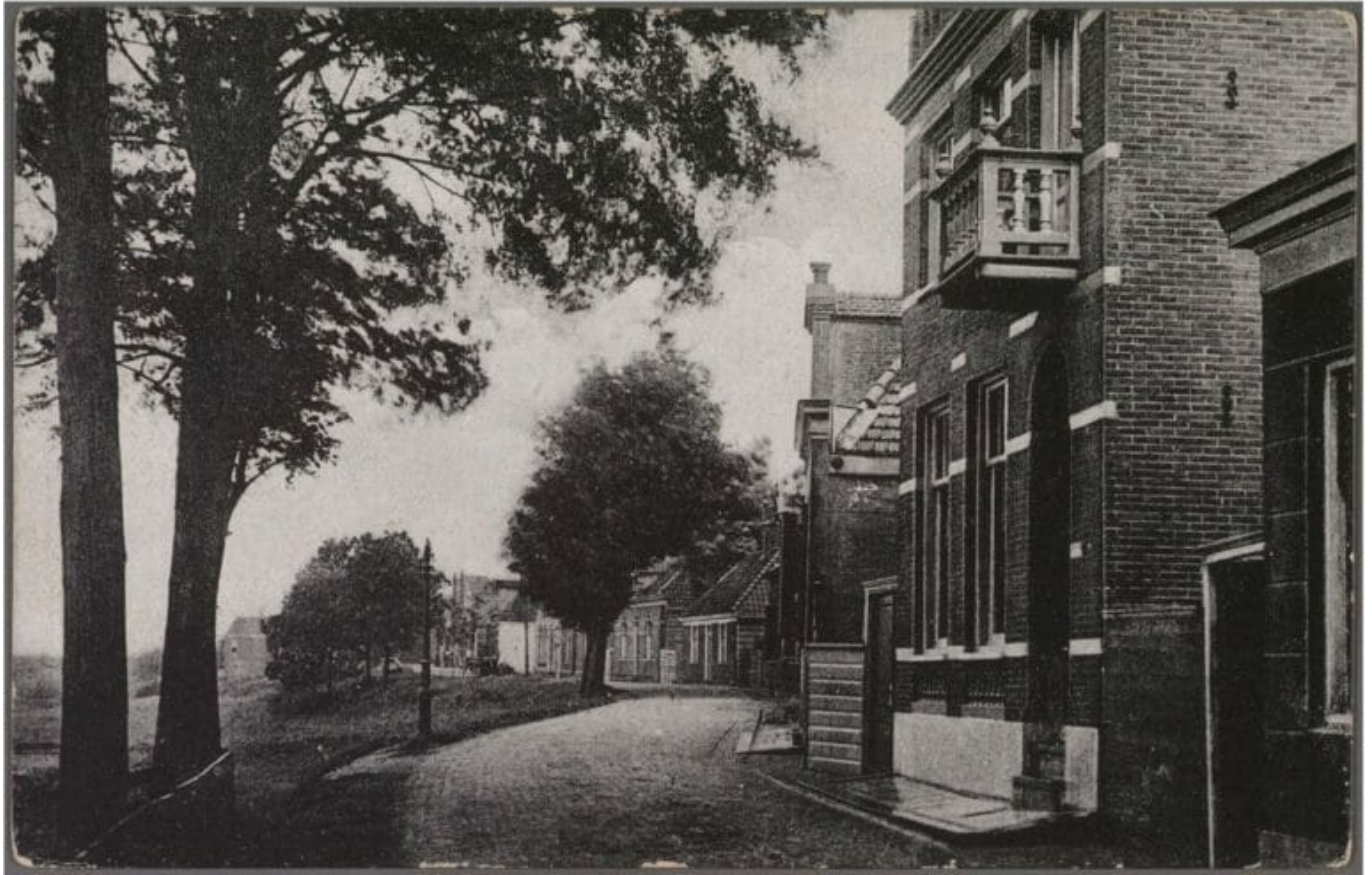
Buiksloot. Het bakstenen huis met balkonnetje is Buiksloterdijk B122 (552) op het nu niet meer bestaande deel van het Westeinde.
