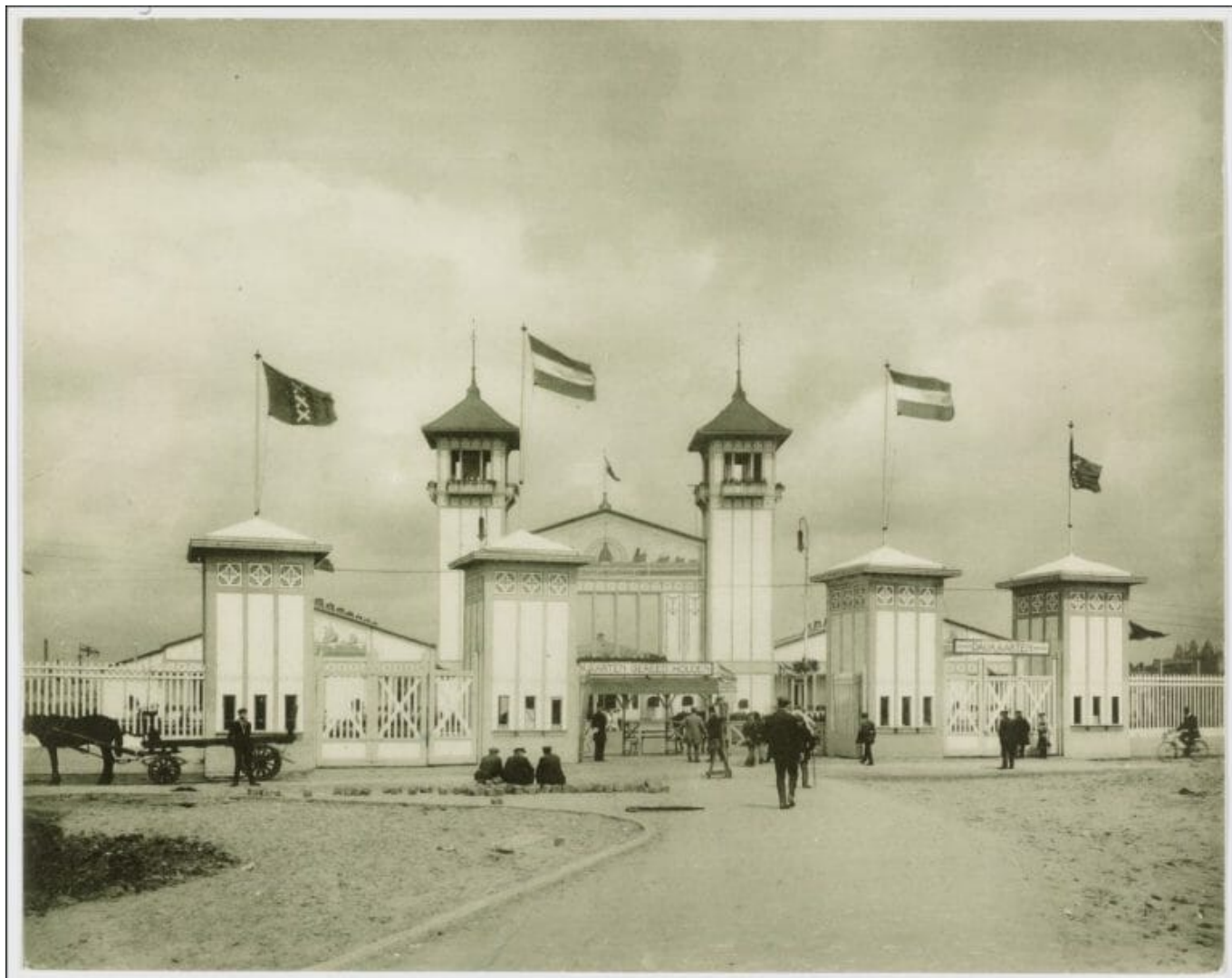
Eerste Nederlandsche Tentoonstelling op Scheepvaartgebied (ENTOS), Buiksloterweg 1. Vooraanzicht van het grote tentoonstellingsgebouw. De tentoonstelling is nog niet officieel geopend, stratenmakers zijn nog bezig het plaveisel van het voorplein te leggen.
