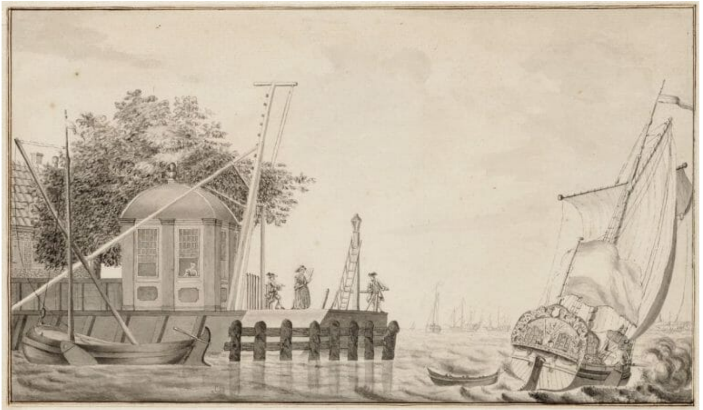
Buiksloterweg, het Tolhuis. Gezien naar het oosten. Links het zomerhuisje of koepel. Rechts een spiegeljacht. Techniek: pen en penseel in grijs. Tekening Jan Spaan.
