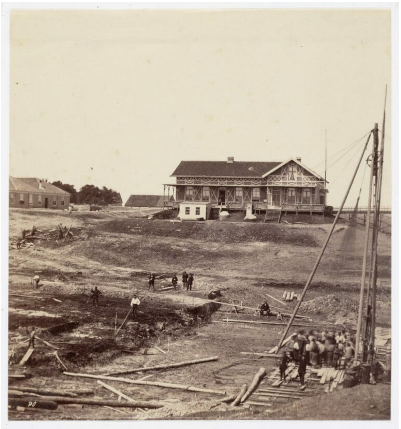
Bouw van schutsluis Willem III. Gezien in westelijke richting. De foto maakt deel uit van een reeks foto's die Pieter Oosterhuis tussen 1861 en 1868 maakte van de bouw van de nieuwe schutsluis Willem III en de restauratie van schutsluis Willem I, beide aan het begin van het Noordhollands Kanaal.
