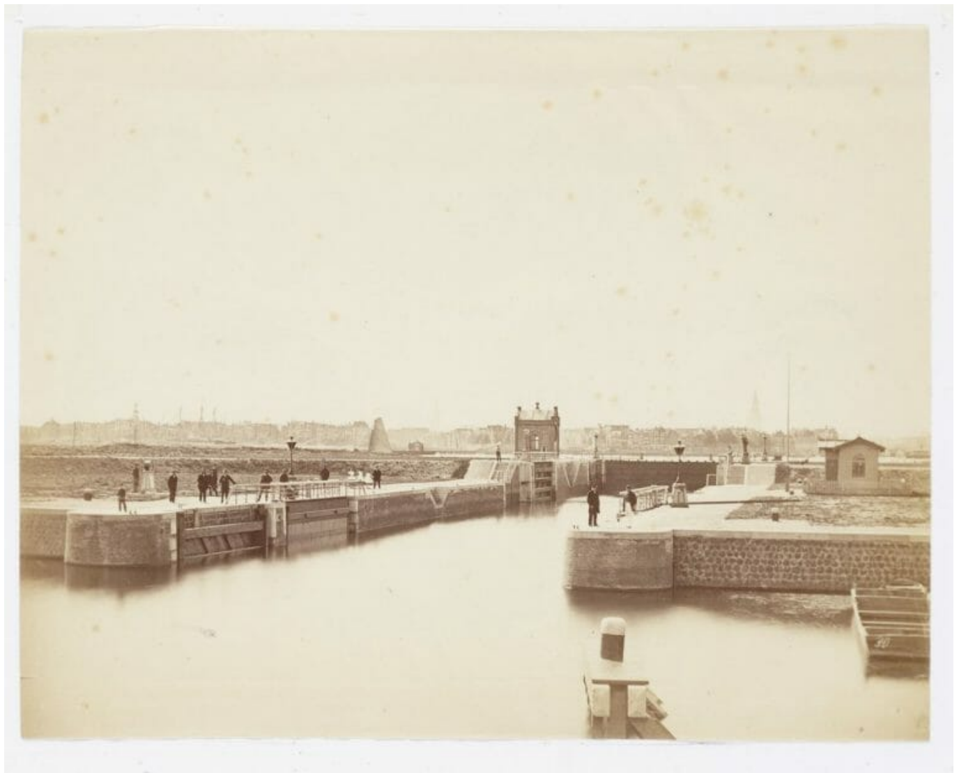
Noord Hollands Kanaal - Bouw van schutsluis Willem III. Schutsluis Willem III vlak na de voltooiing. Gezien in zuidelijke richting. De foto maakt deel uit van een reeks foto's die Pieter Oosterhuis tussen 1861 en 1868 maakte van de bouw van de nieuwe schutsluis Willem III en de restauratie van schutsluis Willem I, beide aan het begin van het Noordhollands Kanaal.
